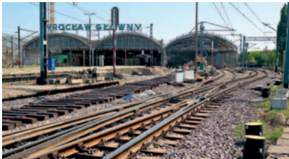
Dworzec Główny we Wrocławiu – projekt w zakresie wbudowywania nawierzchni kolejowej
