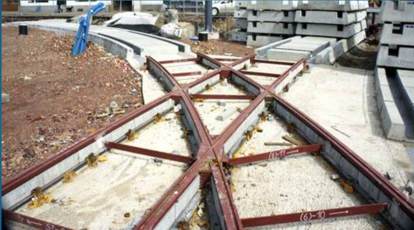
Widok nawierzchni w strefie przejazdu
