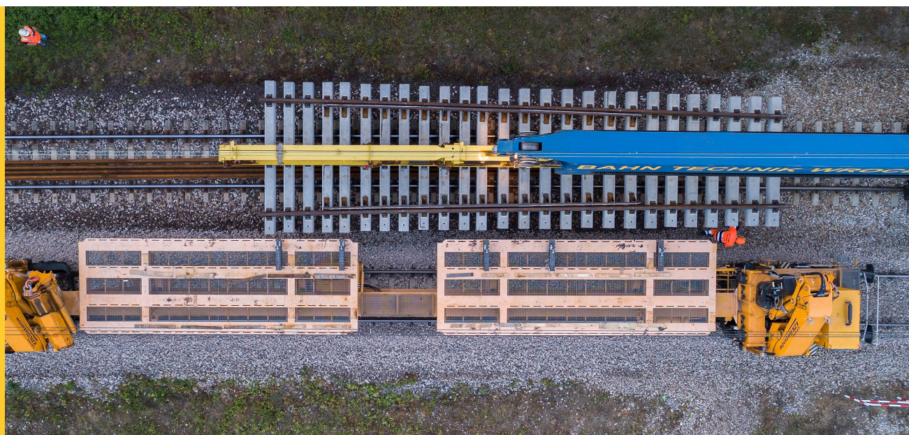
Rozładunek przez żuraw kolejowy Unloading with mobile gantry crane
